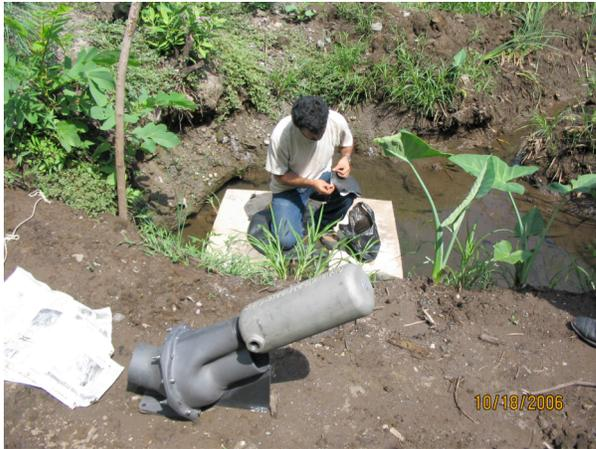
Foto 3: Instalación del sistema de ariete
