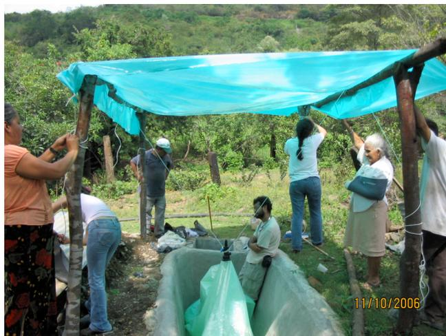
Foto 6: Instalación de biodigesto
